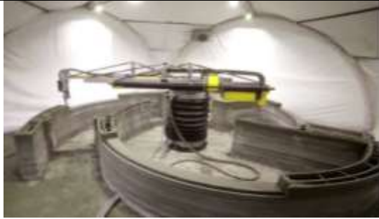
منزل مطبوع باستخدام رغوة الخرسانة والبولى يوريشين السائل للعزل الحرارى بالفراغات جنوب موسكو بروسيا مساحتة 38م 2 فى عام 2016م وذات أرضيات خشبية مع أجهزة من شركة سامسونج وكانت تكلفته هي 10.150 دولار تقريباً
